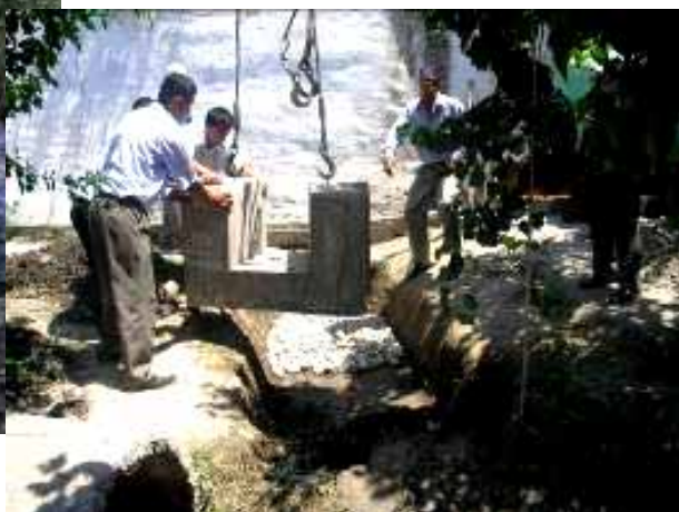
б) монтаж лотка заводского изготовления
