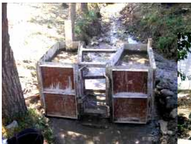
а) при помощи переносной опалубки
